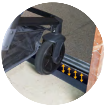
Desníveis entre a cabina e o patamar ao entrar e sair.
